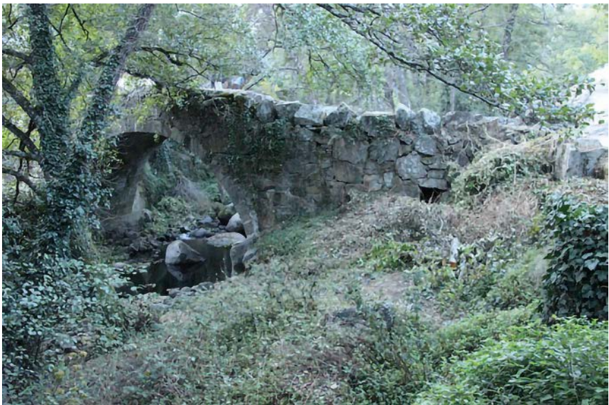
Figura 2. Puente del Salvador y bocín del caz del molino de Faustino Gómez
