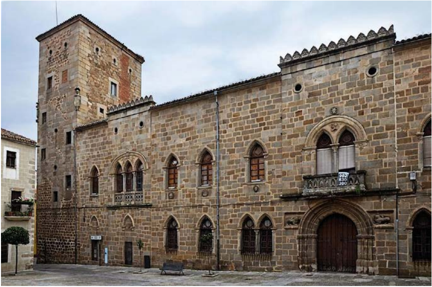
Fachada de la Casa de las Dos Torres en la actualidad, tras su desafortunada restauración con elementos neogóticos
