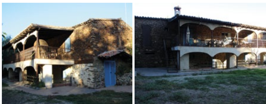
Fig. 18. Aspecto actual del molino del puente de la Caraba.
