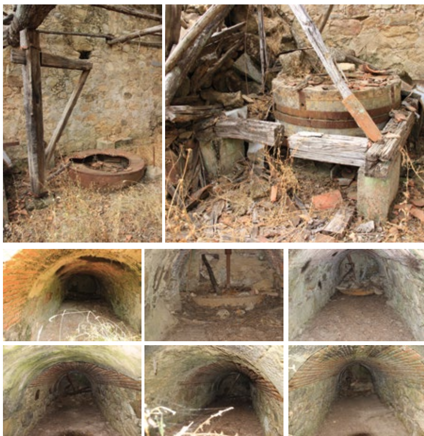
Fig. 7. Molino Nuevo: cabria, guardapolvo, juego de piedras y socacas.
