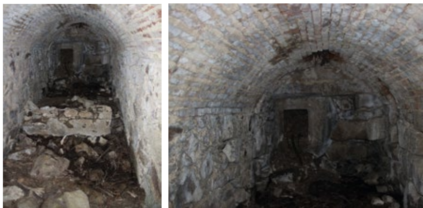
Fig. 11. Molino de los Arjona: socacos y piedra solera en la zona de la dehesa "Los Tejares"
