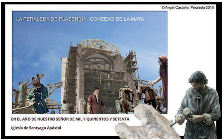
Fig 9- Construcción de la iglesia
