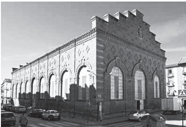
Figura 10. Antiguo mercado de abastos de Linares (Junta de Andalucía)
