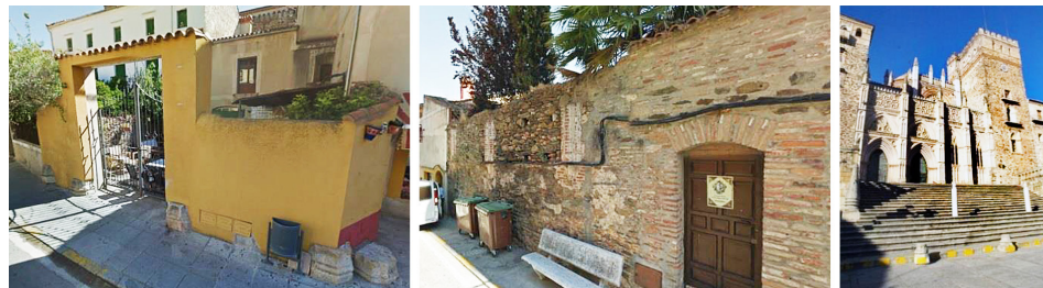
XIV.- Vistas de los restos conservados de la Hospedería Real. Izquierda: basas incrustadas en el muro de una vivienda en su ubicación original. Centro: arcadas del acceso a la Hospedería cegadas e incluidas en el muro actual del Monasterio. Derecha: Basas del claustro de la Hospedería usadas como bolardos frente a la fachada principal del Monasterio.
