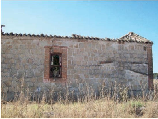
Casa del Guarda Agujas
