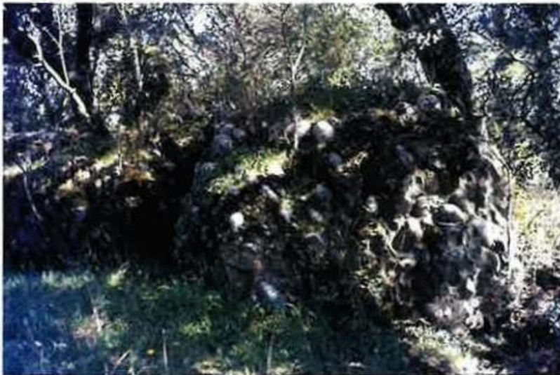
Muro de hormigón de una conducción hidráulica en la Villa romana de la Vega del Castillo (Jaraíz de la Vera)
