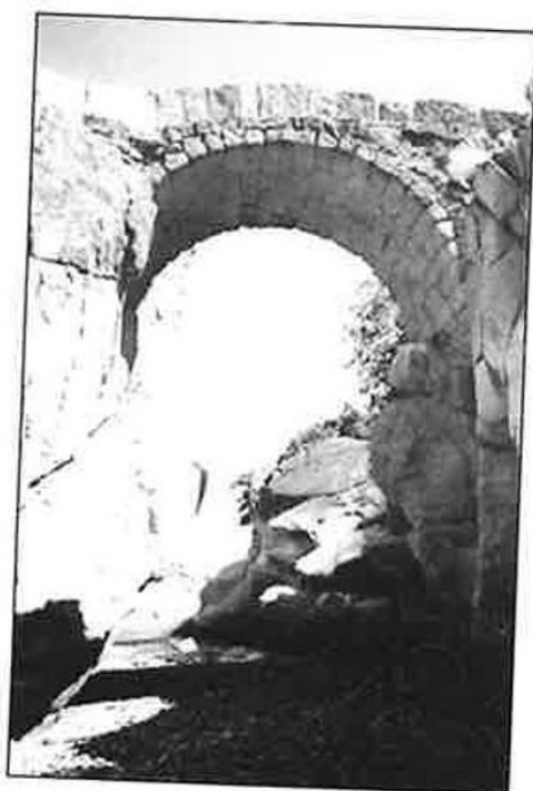
Lám. VII: Puente del Búho. Vista aguas arriba.
