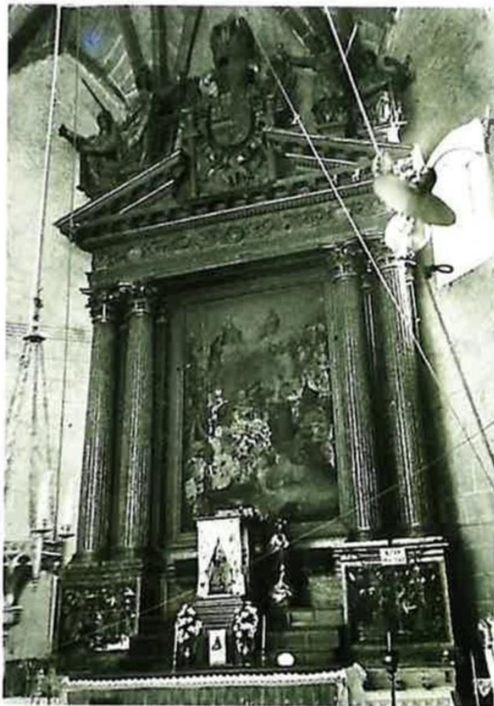
Retablo de Yuste cuando estaba en Casatejada, antes de la restauración
