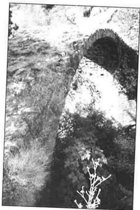
Lám. IV: Puente de Las Veredas. Aguas abajo.
