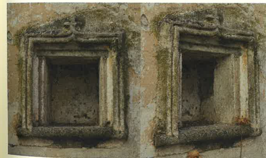
Figura 2. Vista de detalle del sagrario de hornacina en el presbiterio de Torviscoso.
