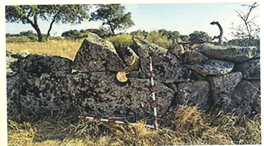
Fig. 8 Muela partida reaprovechada como mampostería en la pared de un cercado
