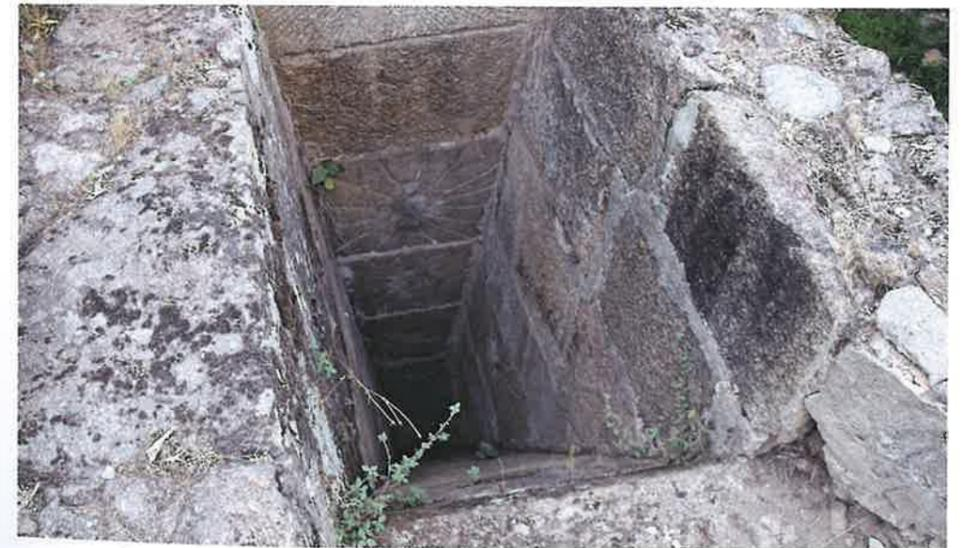
LÁMINA 2. Rampa o cubo. Molino del puente de la Caraba. Collado de la Vera
