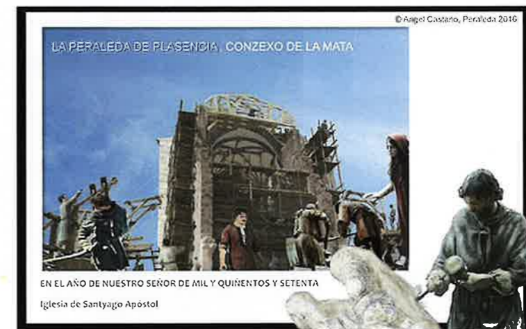
Fig 9- Construcción de la iglesia
