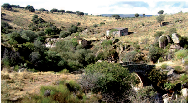
Imagen 14.- Puente del Búho y antiguo molino harinero en el río Gualija, cerca de donde ocurrió la emboscada.
