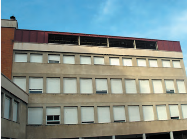
Pabellón nuevo de las Monjas.
